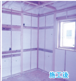
アクアフォーム (断熱材) 施工
